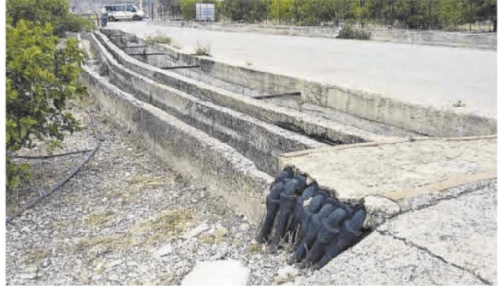
Tuberías de riego por goteo pasan por encima de tres acequias a modo de puente.
